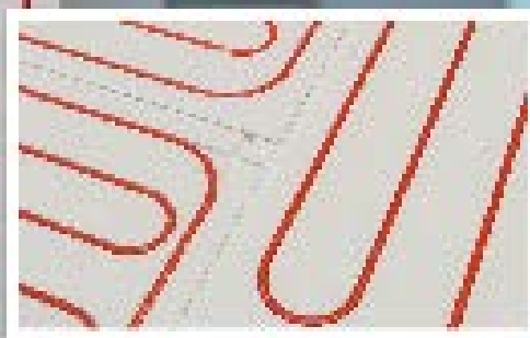
Aquecimento da parede no método por via seca
