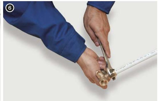
6. A porca da união aparafusada (tubo de ligação) montar ao encaixe com uma chave.
