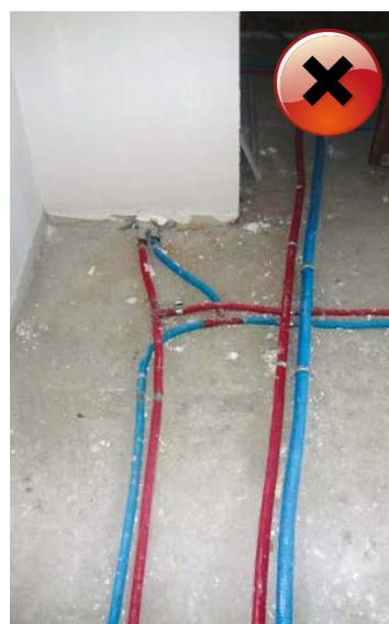
Para eliminar o fenómeno da carga excessiva dos acessórios com a força de flexão não é recomendado dobrar tubos a uma distância menor que 10 diâmetros exteriores dos acessórios.
